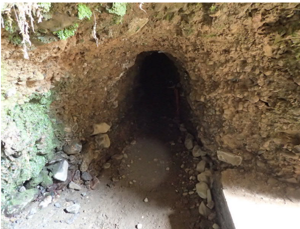
図 20 いなべ市の片樋マンボ。
